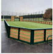
City stade terminé
